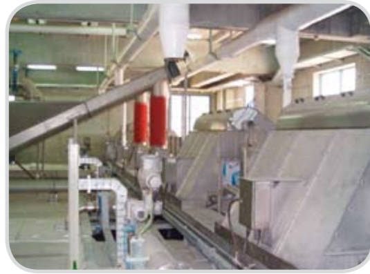
مبنى إزالة المواد الصلبة العالقة Screening Building
