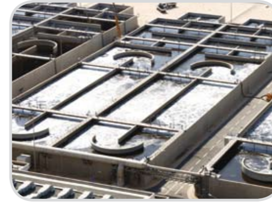
أحواض التهوية Aeration Tanks
