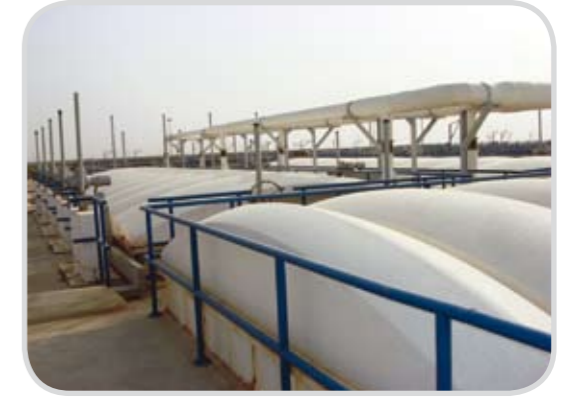
مبنى مدخل المياه بمحطة الصليبية Sulaibiya Inlet Structure
