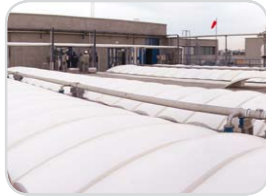
أزالة الرمال والزيوت Sand & Grease Traps at Ardiya
