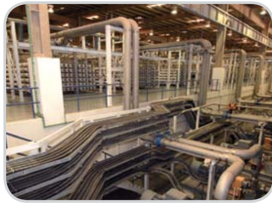
مبنى التناضح العكسي Reverse Osmosis Building
