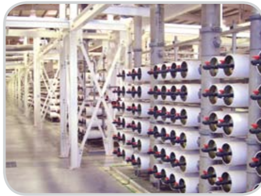
مبنى التناضح العكسي Reverse Osmosis Building
